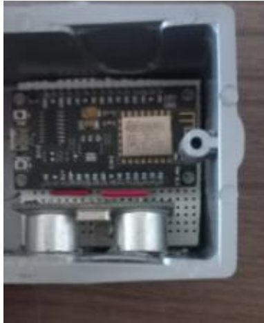
Figura 25: Conexión dentro de la caja de seguridad Fuente(Creación propia)
